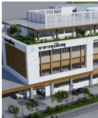
โรงพยาบาลน่าน อาคารอุบัติเหตุ และลานจอดรถ
